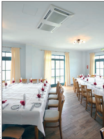
Bild 2: Zur Kühlung der Räumlichkeiten im Erdgeschoss werden die Deckenkassettengeräte »Melody WA 63« und »Melody WA 123 2 TFC« eingesetzt
