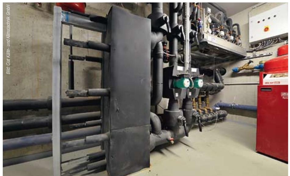
Ein geschraubter Plattenwärmeübertrager trennt den Grundwasserkreislauf von dem internen Kühl-/Kaltwasserkreislauf, weil dieser sowohl als Wärmequelle für die Wärmepumpe als auch zur direkten Kühlung der Gastronomie und Tagungsräume genutzt wird.
