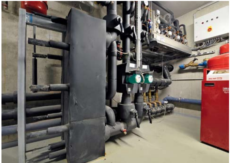
Der geschraubte Plattenwärmetauscher trennt den Grundwasserkreislauf von dem internen Wasserkreislauf. Dieser dient sowohl als Wärmequelle für die Wärmepumpe als auch zur direkten Kühlung der Räumlichkeiten im Erdgeschoss über diverse Deckenkassettengeräte
